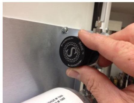
Рисунок 8: Установочный винт регулятора Scott Рисунок 9: Регулировочная ручка
